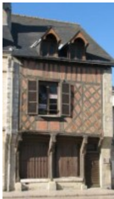
La maison médiévale
